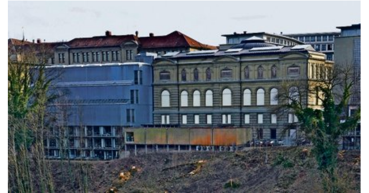
Der Atelier-5-Bau (links) des Kunstmuseums Bern ist baufällig. Stefan Andereg
